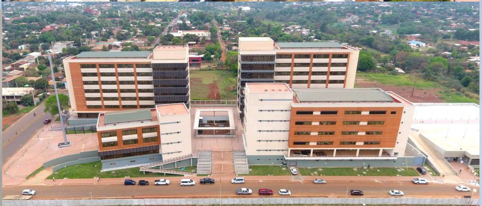
OFICINAS DE GOBIERNO - MOPC FEDERAL GOVERNMENT OFFICE BUILDINGS COMPLEX - MOPC
