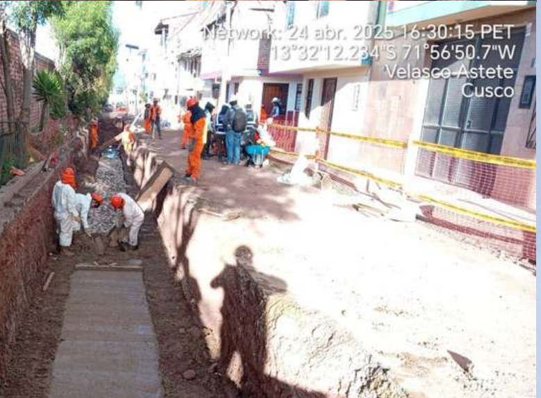
LIBERACIÓN DE FUNDACIÓN EN SISTEMA QUIÑONES
