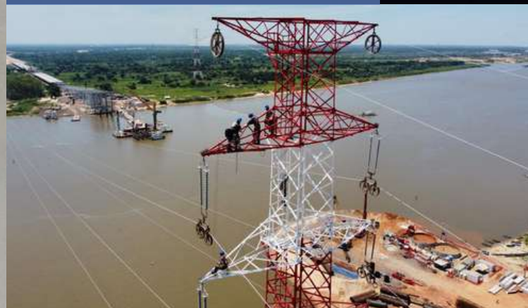
AMPLIACIÓN DE LA SUBESTACIÓN DE CAAGUAZÚ EXPANSION OF THE CAAGUAZÚ SUBSTATION
