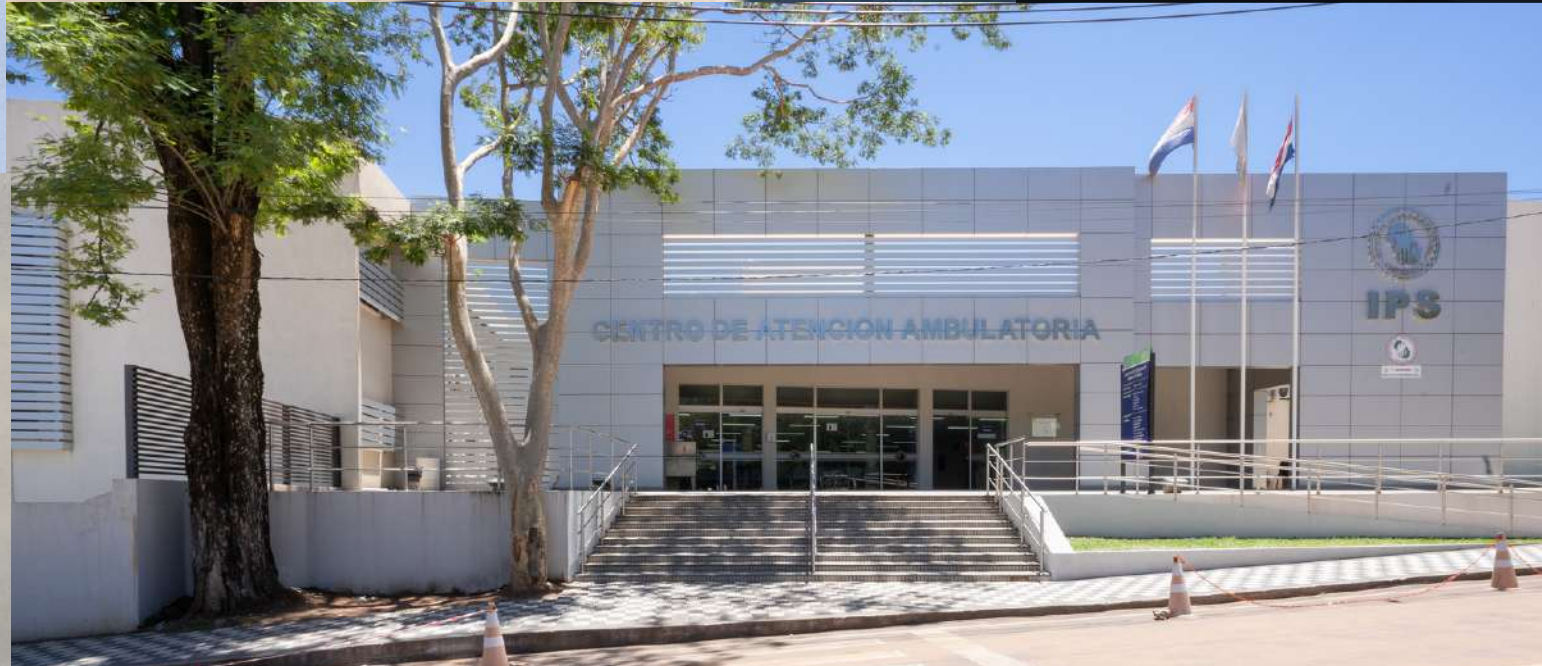
HOSPITAL REGIONAL DE CIUDAD DEL ESTE - IPS REGIONAL HOSPITAL , CIUDAD DEL ESTE - IPS
